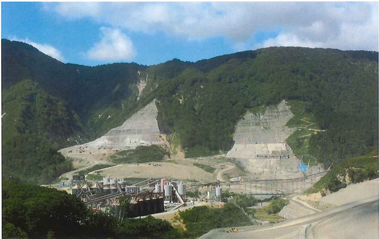
展望台より 成瀬ダム堤体打設工事・設備の様子
