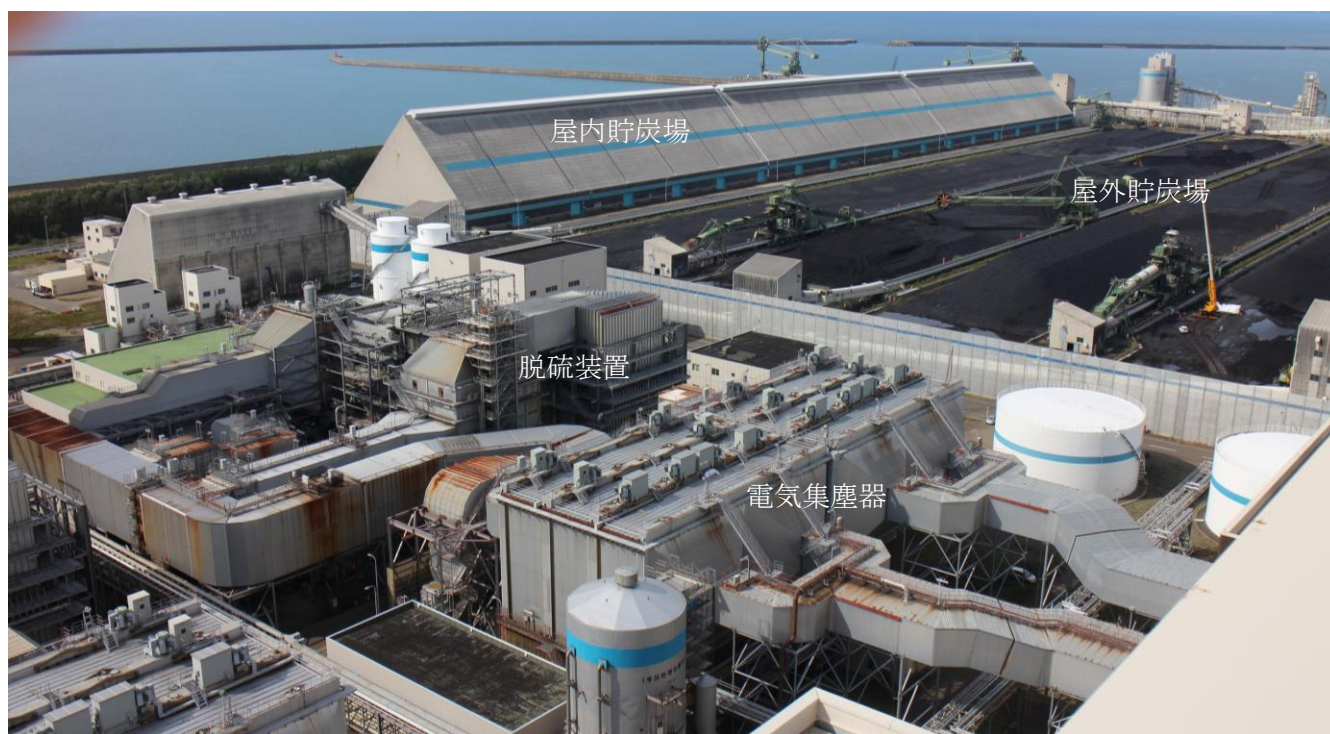
【タービン建屋屋上より】
